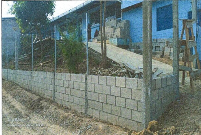
Foto 1: Proceso de Mejoramiento de cerramiento perimetral del centro educativo.
